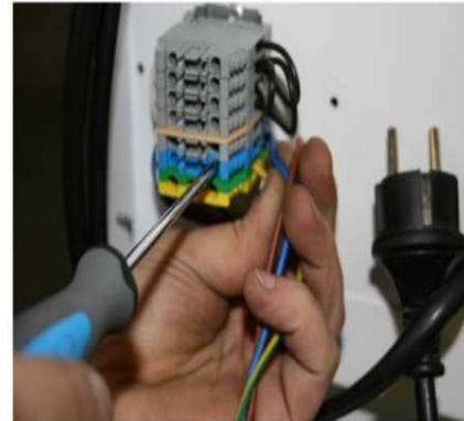
5 Elektrik ve uzak nem ayarlayıcı kablolarını bağlayın.
